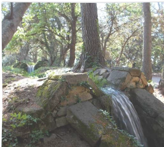
Desserte en eau sur le secteur de Sarrians par Le Canal de Carpentras
