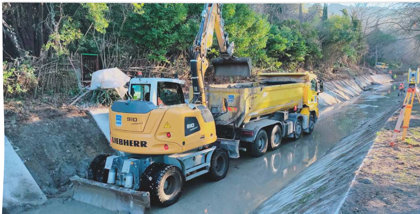
Travaux de préparation au couvlage menés sur le canal de l'Union Luberon Sorgue Ventoux © Canal de l'Isle
