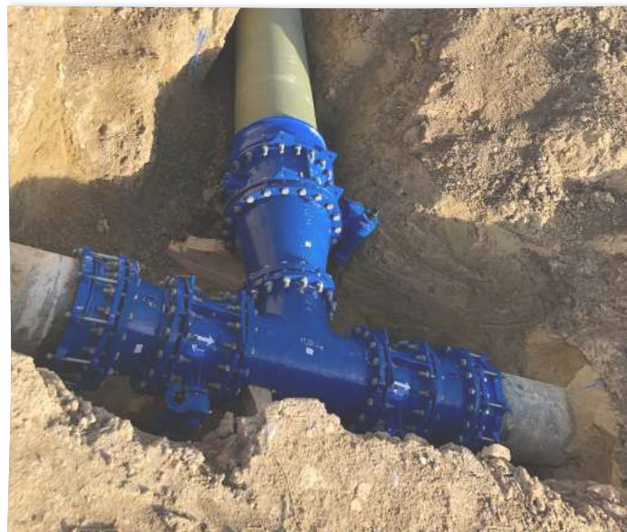
Travaux sur les canalisations à Bedoin © Canal de Carpentras
