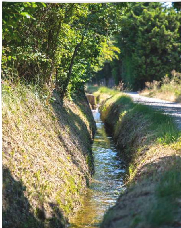
Filiole gravitaire sur le canal du Cabedan Neuf © Canal du Cabedan-Neuf
