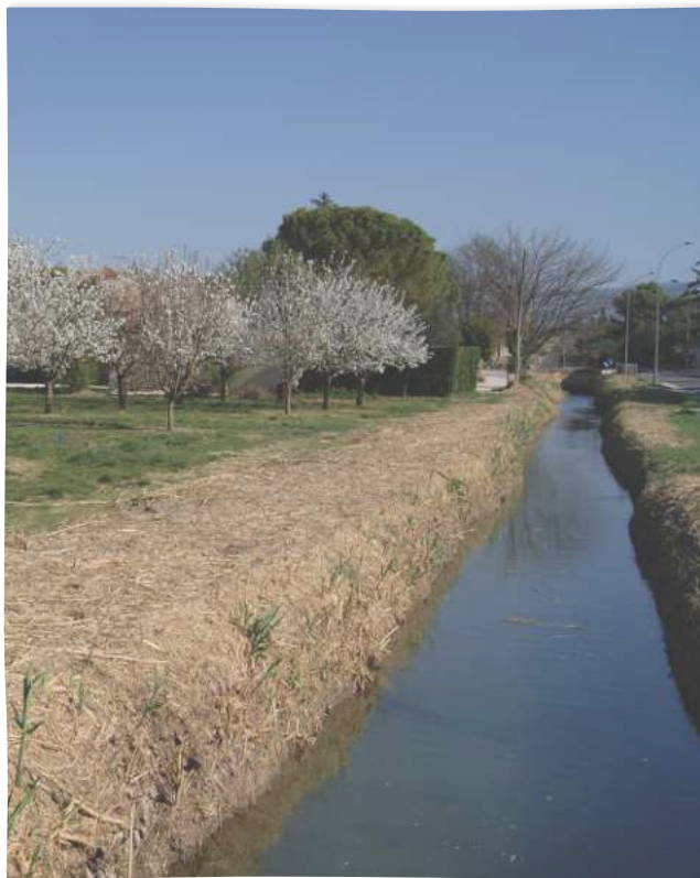
Canal principal de l'Isle © Canal de l'Isle
