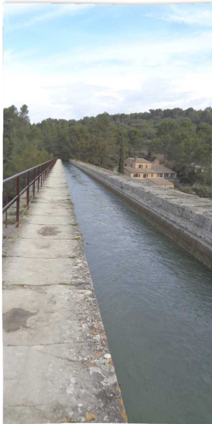
L'aqueduc de Galas permet d'enjamber la Sorgue. © Canal de Carpentras
