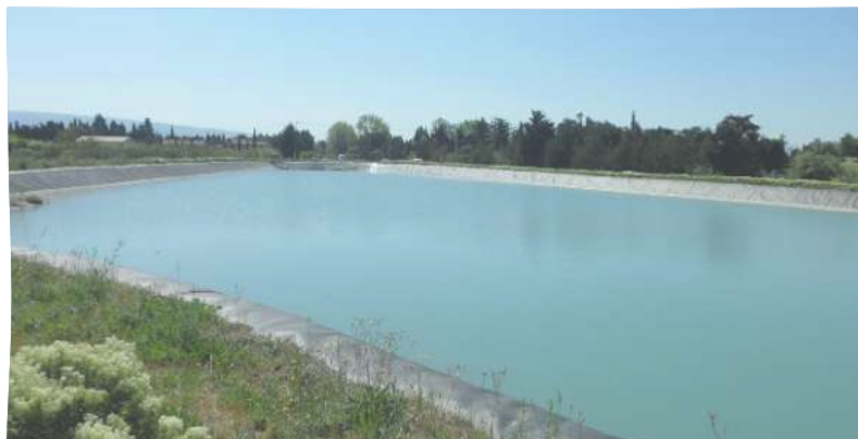
Bassin de régulation de Peyreras sur la commune de l'Isle-sur-la-Sorgue
