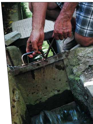
Ouverture d'une martelière.
