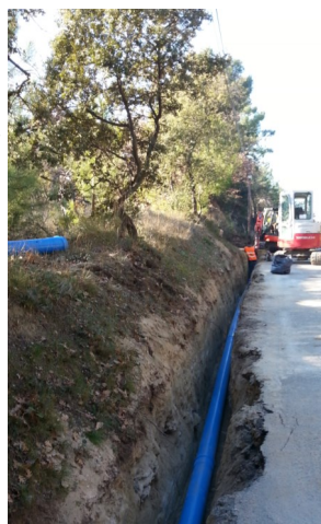
Travaux d'extension à Bedoin
